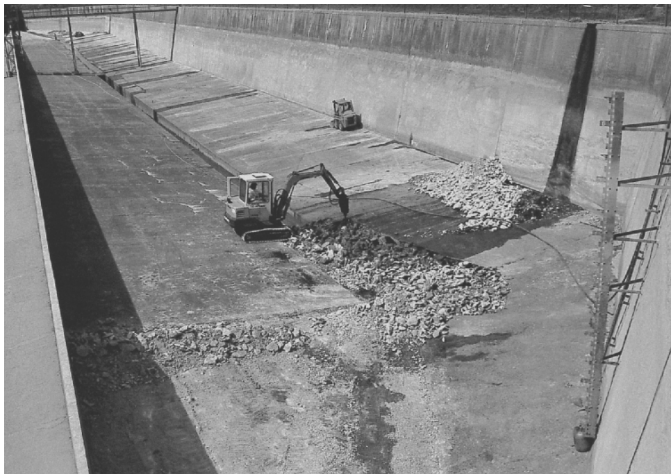
Rénovation du fond du bassin de compensation.
