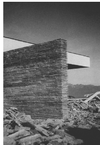
4 juin 1957. Montage du mur en pierre naturelle – granit du Tessin – qui intègre la cheminée tout en se dépliant en longueur, créant une relation entre l'intérieur et l'extérieur.
