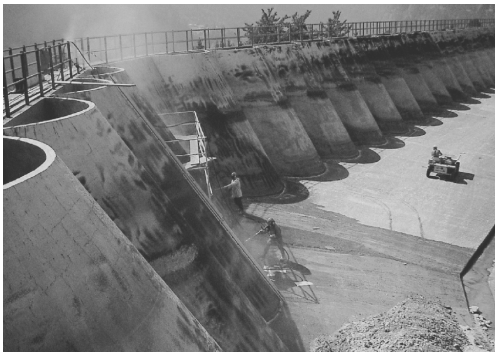
Rénovation de l'extrados des voûtes.
