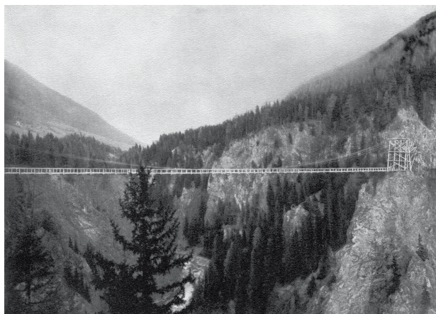
Richard Coray: passerelle pour la construction de la voie du train rhétique près de Wiesen (1905/1906). Tiré de Gerüst- und Seilriesenbauer Richard Coray von Trins, op. cit.
