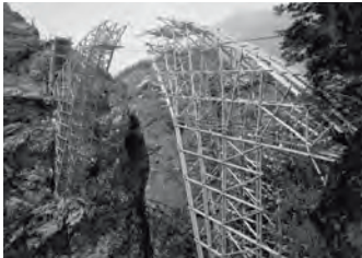
Richard Coray: cintre du pont de Gmündertobel (Appenzell). Tiré de Gerüst- und Seilriesenbauer Richard Coray von Trins, op. cit.
