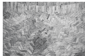
Eglise de Santa Sofia, Padoue, XI e siècle env. Appareil de brique en épis de la semi-coupole de l'abside.
