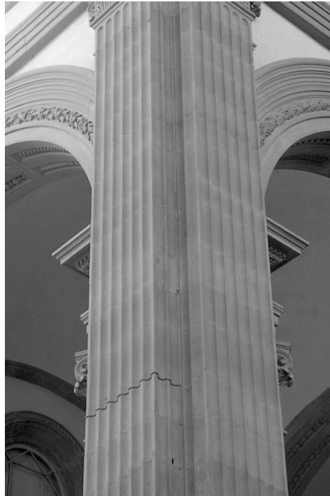
Détails des pilastres cannelés d'un piédroit de la croisée, dans la basilique San Lorenzo. A droite, à San Spirito, détail d'une demi-colonne au fût lisse.
