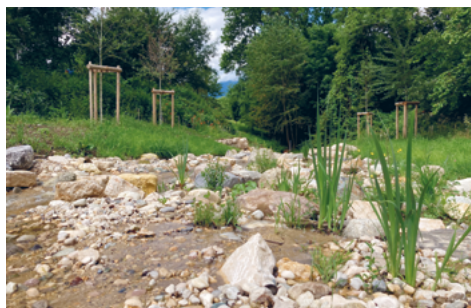
Fig. VII.1.9 Création d'une rampe rugueuse permettant d'intégrer des pentes de profil en long importantes (3 à 5 %) sur certains secteurs (remise à ciel ouvert du ruisseau de Mivellaz à Corcelles-sur-Chavornay, Vaud).
