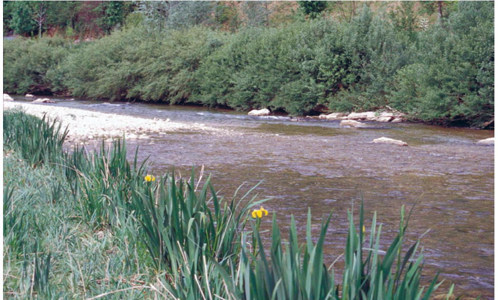
Fig. VII.2.8 Exemple de cours d'eau d'apparence naturelle, entièrement aménagé avec les successions de techniques suivantes : ensemencement de prairie et fascine d'hélophytes à gauche, fascine de saules et plantation de ligneux à droite.
