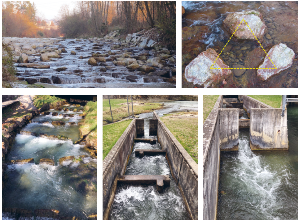
Fig. VII.3.8 Types d'ouvrages migratoires de montaison (de gauche à droite, et de bas en haut) : rampe intégrale, disposition des blocs, passe en enrochements, passe à fentes verticales, et son courant d'attrait.
