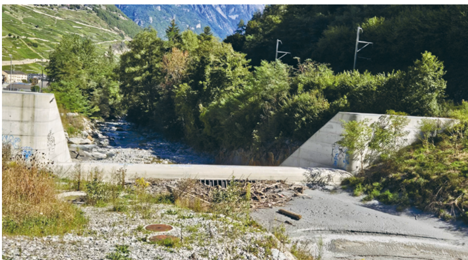
Fig. I.3.6 Ouvrage de contrôle du transit sédimentaire sur la Dranse, en amont de Martigny (VS), après les fortes crues de 2025.
