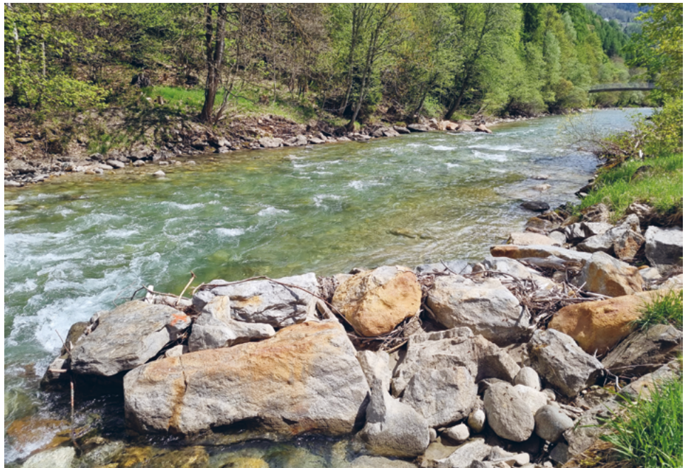
Fig. IX.4.10 Épi à blocs permettant de structurer le lit de la rivière.
