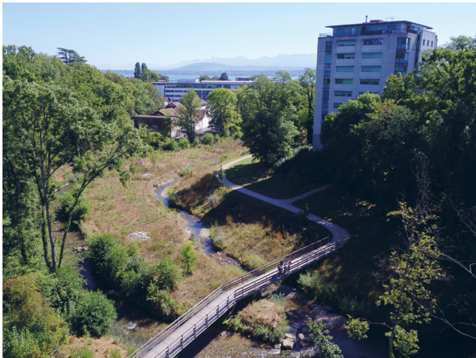
Fig. VI.1.3 La Versoix après les travaux de 2015, secteur Molard, avec élargissement du lit majeur pour les crues.
