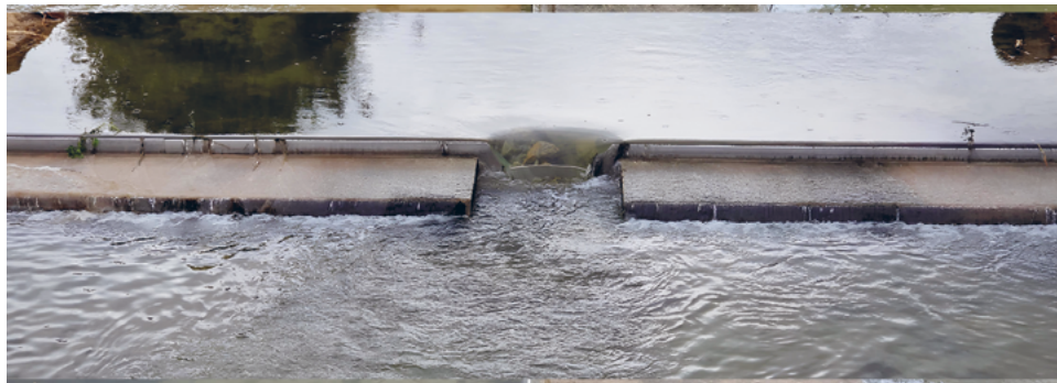
Fig. X.2.9 Vue frontale du nouveau déversoir trapézoïdal du pont de Praleta, réalisé par adaptation d'un ancien seuil en béton.
