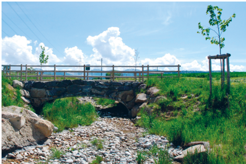
Fig. VII.1.16 Aménagement d'un ouvrage de franchissement de type demi-buse permettant la création d'un fond de lit naturel, sans rupture de fonctionnalité écologique (remise à ciel ouvert de la Goletta, à Bossonnens, canton de Fribourg).
