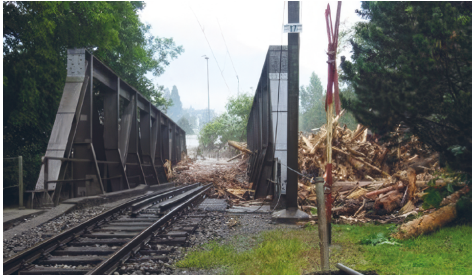
Fig. III.2.9 Obstruction par bois flottant (embâcle) au pont ferroviaire de Sarnen. Photo: belop GmbH
