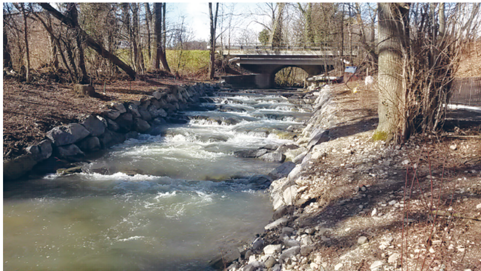
Fig. III.1.13 Dissipation de l'énergie de l'écoulement par ressauts successifs dans l'aménagement d'une échelle à poissons sur le Boiron de Morges (Vaud).
