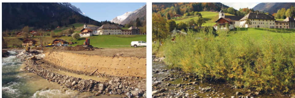
Fig. VII.2.1 À gauche: chantier de génie végétal en cours. À droite: l'aménagement évolue progressivement en une structure végétale techniquement et écologiquement fonctionnelle, qui est parfaitement intégrée dans le paysage.
