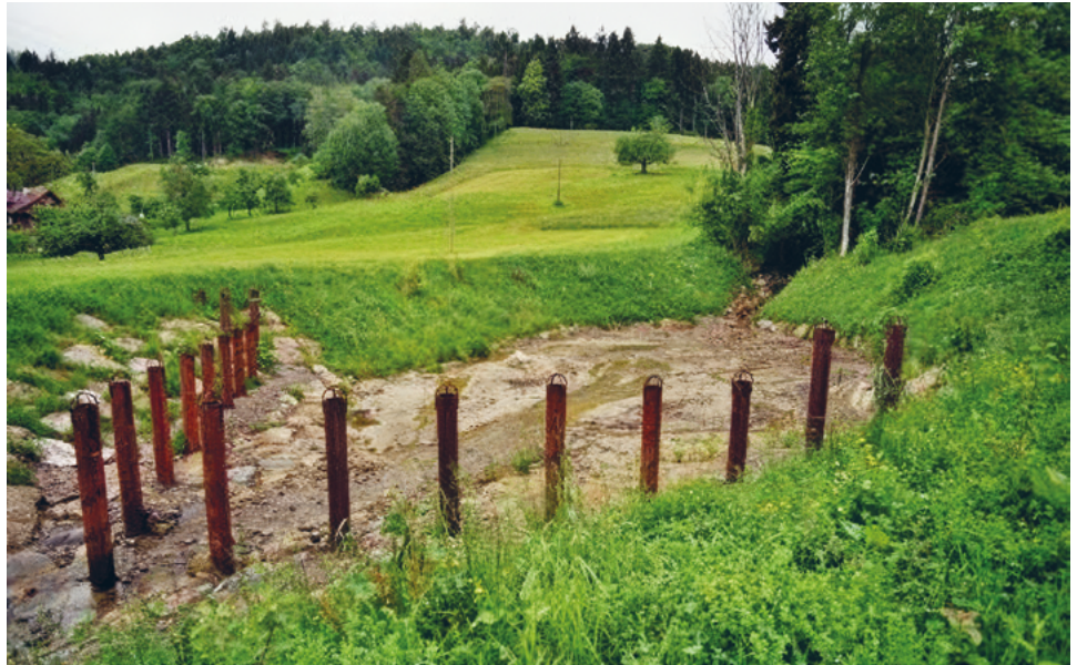
Fig. III.2.10 Exemple de grille de rétention pour le bois flottant. Photo: Basler & Hofmann
