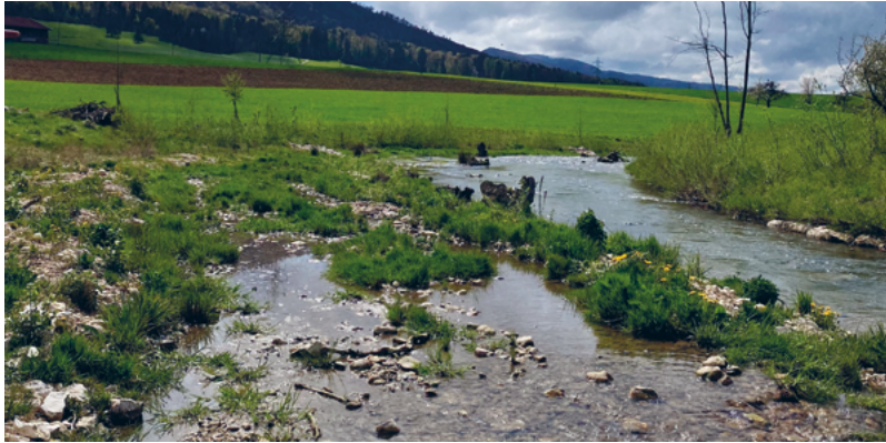
Fig. VII.1.10 Création d'une terrasse basse inondable et érodable favorable au développement naturel d'un milieu humide au bord de l'eau et amélioration de la morphologie du lit mineur avec la mise en place de souches arrimées (revitalisation de la Scheulte au Val Terbi, Jura).
