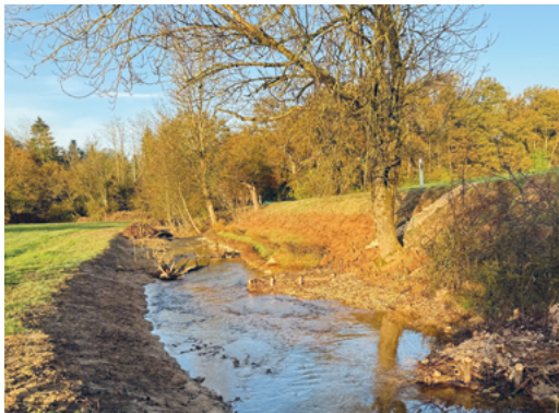
Fig. VII.1.7 À gauche: diversification de la largeur et de la morphologie du lit mineur par la mise en place de souches et d'épis en bois, stabilisation de la berge gauche (route cantonale) à l'aide du génie biologique (revitalisation de l'Allaine à Miécourt, Jura).
