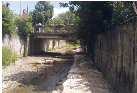
Fig. V.4.8 Exemples d'aménagements de banquettes favorables à la petite faune.
