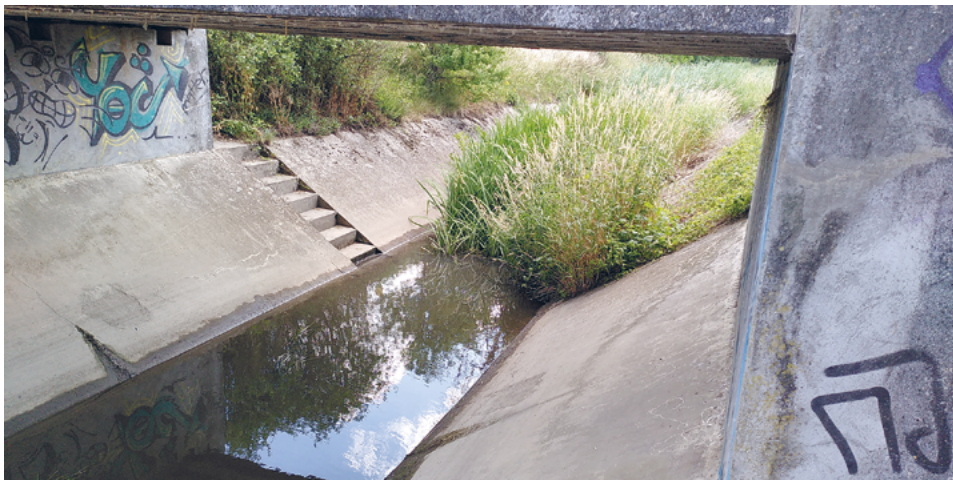
Fig. V.4.9 Exemples d'aménagements ne permettant pas le passage de la faune terrestre.
