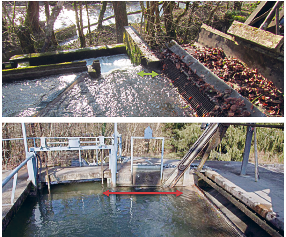
Fig. VII.3.6 Positionnement de l'entrée du dispositif de dévalaison sur deux ouvrages hydroélectriques sur la Versoix. En haut : l'entrée est presque à hauteur du plan de grille (flèche verte), le poisson n'a pas à « reculer » pour trouver l'exutoire de dévalaison. La dévalaison est efficace. En bas : l'entrée est trop en retrait de la grille de protection des turbines (flèche rouge), celle-ci ne guide pas le poisson. L'individu va « buter » contre la grille, et devra repartir en arrière pour trouver l'entrée du dispositif. La dévalaison n'est pas efficace.
