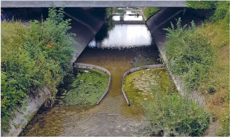
Fig. X.2.6 La station de mesure Bossenailles sur l'Aire, constituée d'un canal de type Venturi pour la mesure des faibles débits.
