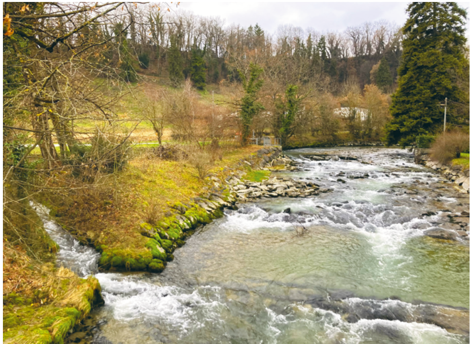
Fig. I.3.5 Passe à poissons en bassins alternés, au Moulin de Lavaux sur l'Aubonne (VD). Photo: J.-L. Boillat
