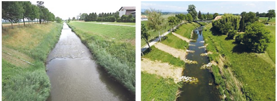
Fig. III.2.3 Tronçons de la Broye. À gauche: à renaturer en aval du Pont Neuf. À droite: épis réalisés en 2020, en amont du Pont Neuf.
