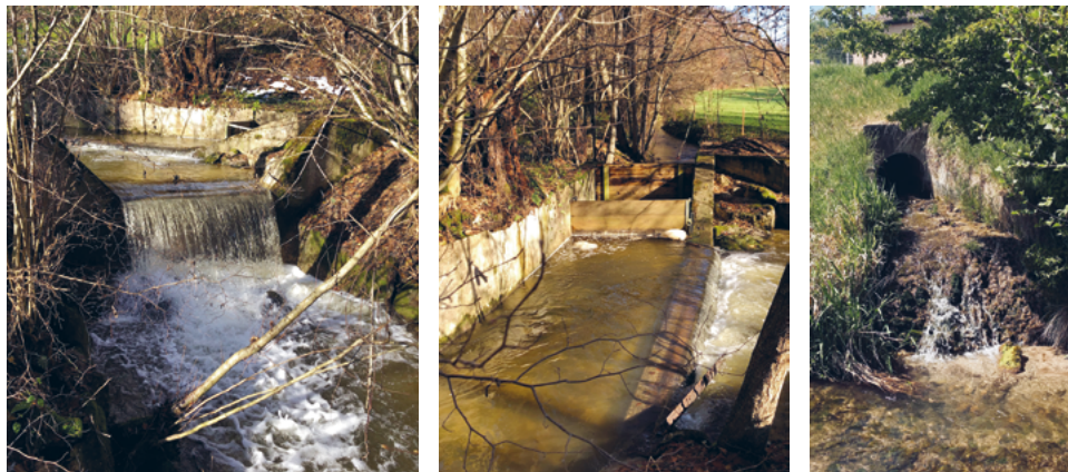
Fig. VII.3.2 Exemples d'obstacles migratoires sur les affluents: seuil (à gauche), prise d'eau (au centre) et ponceau surélevé (à droite). Photos: J.-M. Ribí
