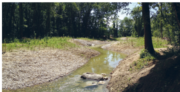
Fig. VII.1.6 Terrassement en déblai d'un lit mineur volontairement sous-dimensionné (à gauche) afin de laisser le cours d'eau tracer ses propres courbes au gré des crues (à droite). Revitalisation d'un ancien bras de l'Aire à Confignon (canton de Genève). Photos : BIOTEC
