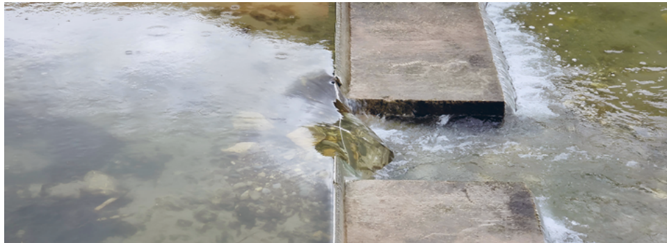
Fig. X.2.8 Vue transversale du nouveau déversoir du pont de Praleta. On observe le cône de dépression de la surface d'eau en amont de la chute, et l'écoulement à la hauteur critique au droit de la chute.
