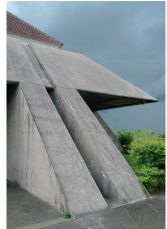
Détail des angles et des gouttières. Relation entre intérieur et extérieur.
