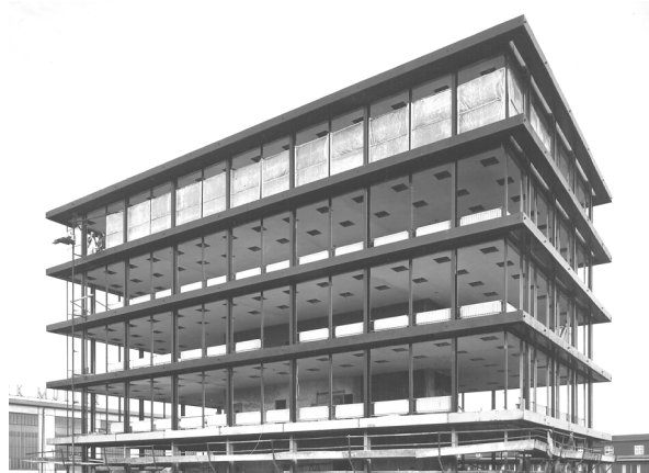
Fig. 9.5 Bâtiment administratif : les planchers sont des dalles en béton armé solidaires des sommiers métalliques. (Source : Construire en acier 2 , Centre Suisse de la Construction Métallique, Zürich, 1962.)
