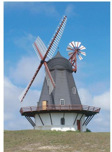
**FIGURE 7.1** Moulin à vent à galerie. La calotte supérieure, qui supporte les ailes, est orientable et la galerie permet au meunier d'orienter les ailes face au vent. (Photo: Chris Nyborg (CC)).
