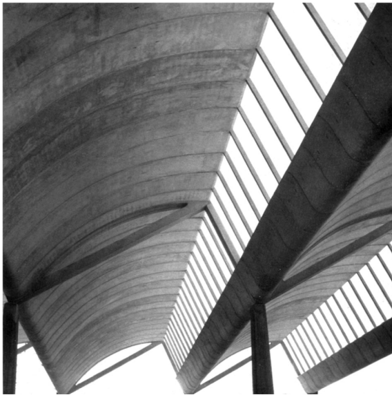
Fig. 8.9 Coque cylindrique en shed ; (a) coupe ; (b) principe de la précontrainte (\vec{P}_1 + \vec{P}_2 + \vec{P}_3 = \vec{Q}) ; (c) vue intérieure ; (d) élément préfabriqué.
