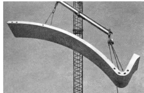
Fig. 8.9 Coque cylindrique en shed ; (a) coupe ; (b) principe de la précontrainte (\vec{P}_1 + \vec{P}_2 + \vec{P}_3 = \vec{Q}) ; (c) vue intérieure ; (d) élément préfabriqué.
